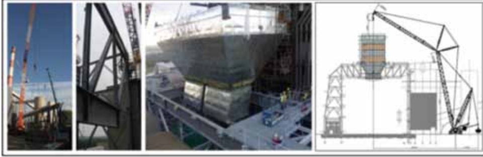
Şekil 10 - Kapatma sırasındaki inşa faaliyetleri / Figure 10 – Erection activities during shutdown
