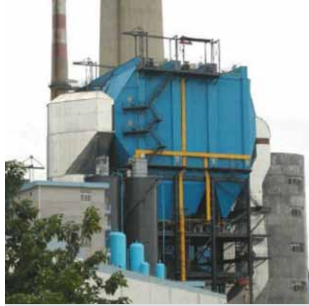
Şekil 3: Almanya'daki yarı kuru kurulum (arada kuru gaz yıkayıcı ile birlikte) Figure 3 : Semi-dry installation in Germany (with a dry scrubber in between)
