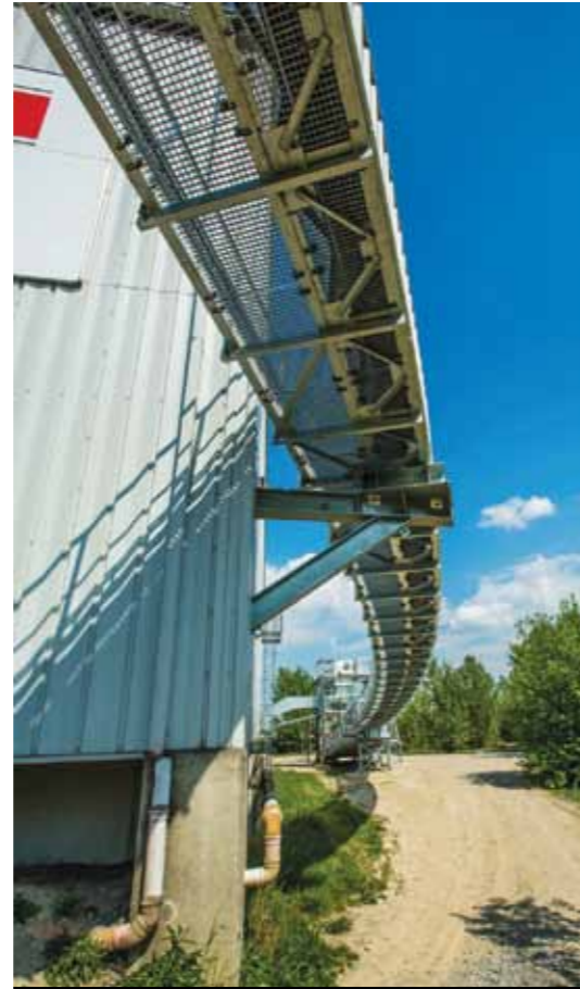
Resim 4: İlk destek, doğrudan depoya monte ediliyor. Picture 4: The first support is mounted directly to the storehouse.
