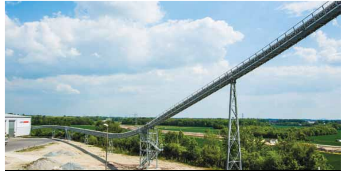
Resim 5: Boru Konveyörün eğimi gösterilen noktada 18,6 derece olarak ölçülmektedir. Picture 5: The inclination of the Pipe Conveyor measures 18.6 degrees at the point shown.
