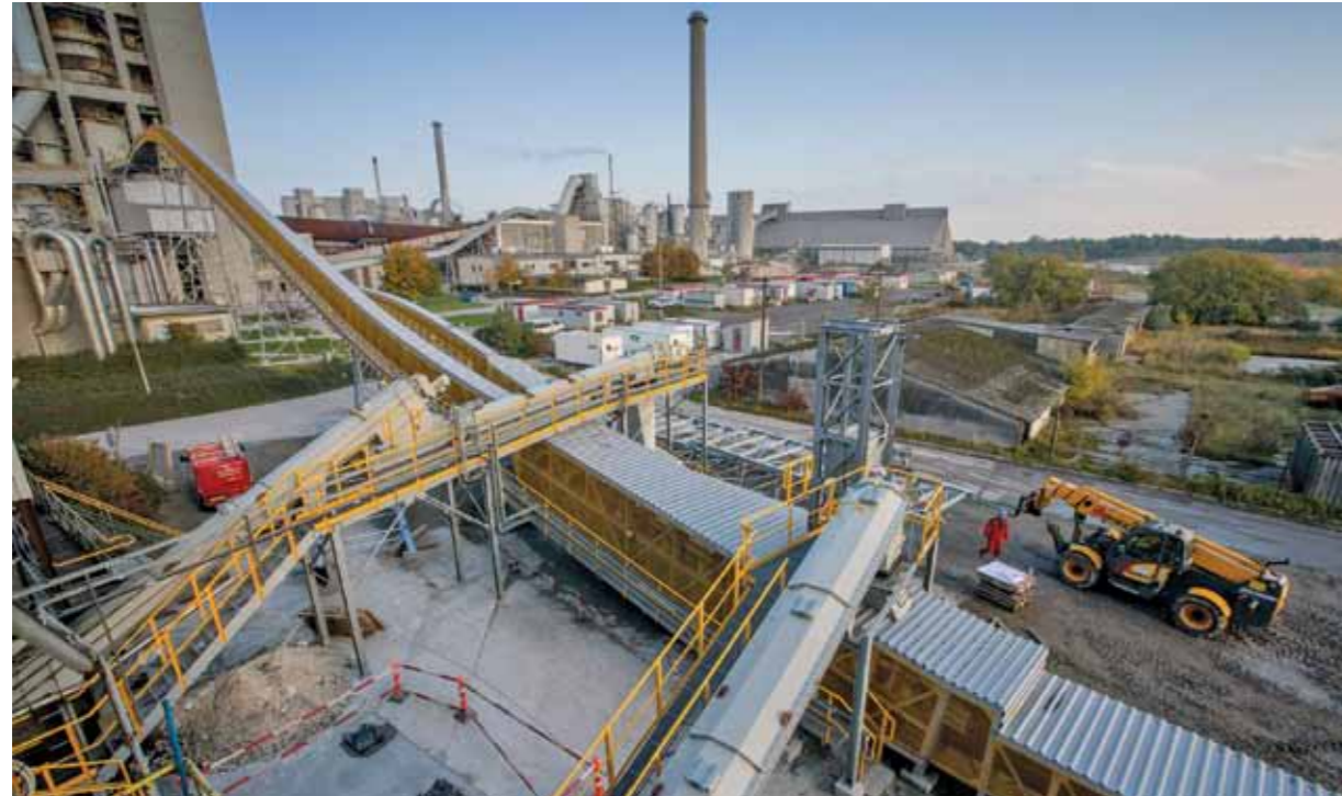
Şekil 1: Kalsinatör ve ana brülörün alternatif yakıtlar ve hammaddeleri beslenmesini sağlamak için BEUMER Group Aalborg Portland'a bir tam sistem tedarik etti. Sistemin en önemli kısmı boru konveyörlerdir. Onlar helezon konveyörler aracılığıyla beslenmektedir.
