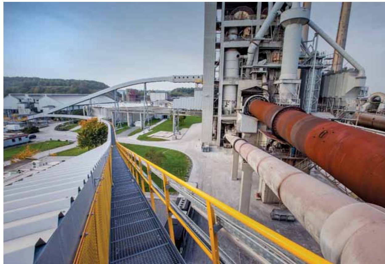
Şekil 3: İki boru konveyör: BEUMER Group çeşitli dökme malzemeler için çeşitli sistem çözümleri gerçekleştirmiştir. Picture 3: The two Pipe Conveyors: BEUMER Group realises different system solutions for the various bulk materials.
