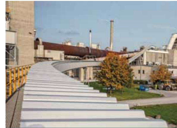
Şekil 4: Boru konveyör malzemeyi doğrudan döner fırına taşımaktadır. Konstrüksiyonunda bükülmeler kolayca gerçekleştirilebilir.
